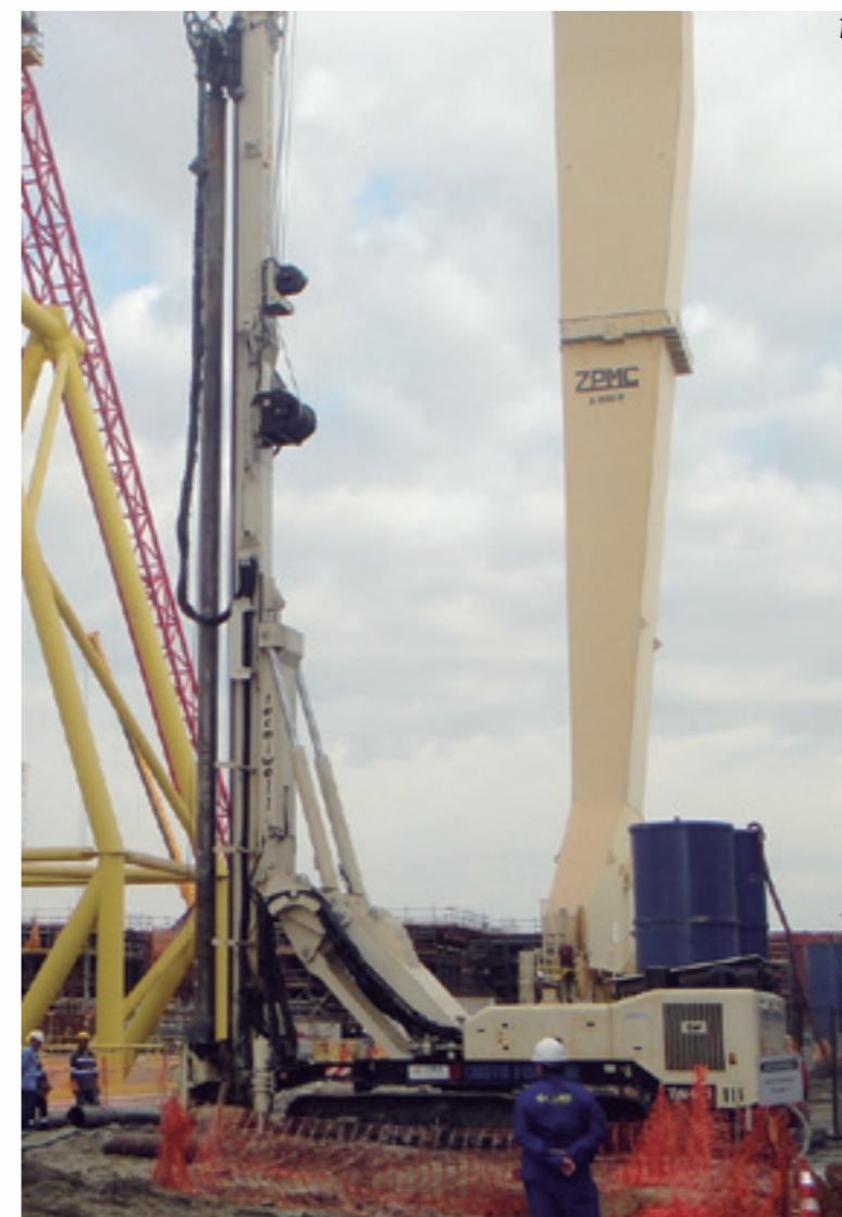
1 - Execução das estacas raiz em rocha
