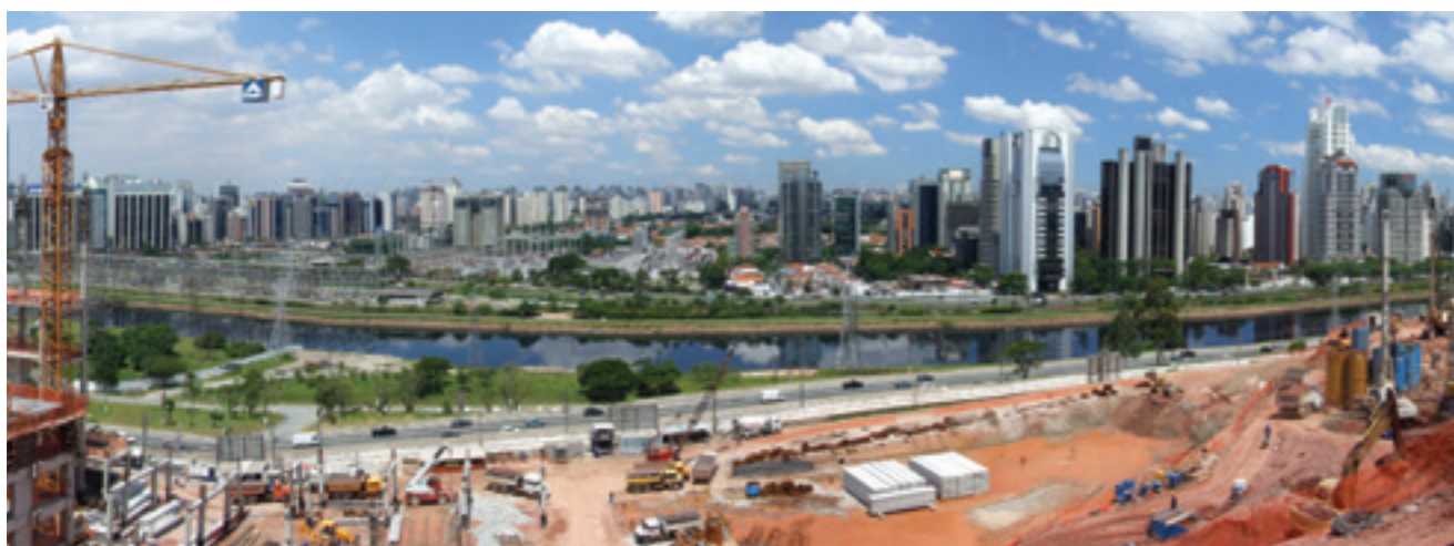
1 e 2 - Vistas das paredes atirantadas de um futuro sub-solo. 3 - Vista panorâmica das obras do complexo imobiliário Cidade Jardim.
