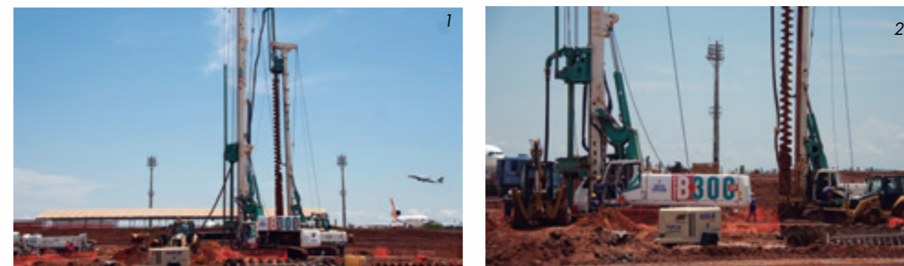
1 - Vista dos equipamentos Casagrande B300XP e B125.
