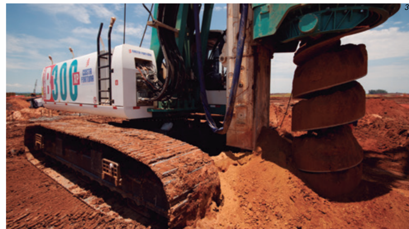
3 - Detalhe da execução de hélice contínua.
