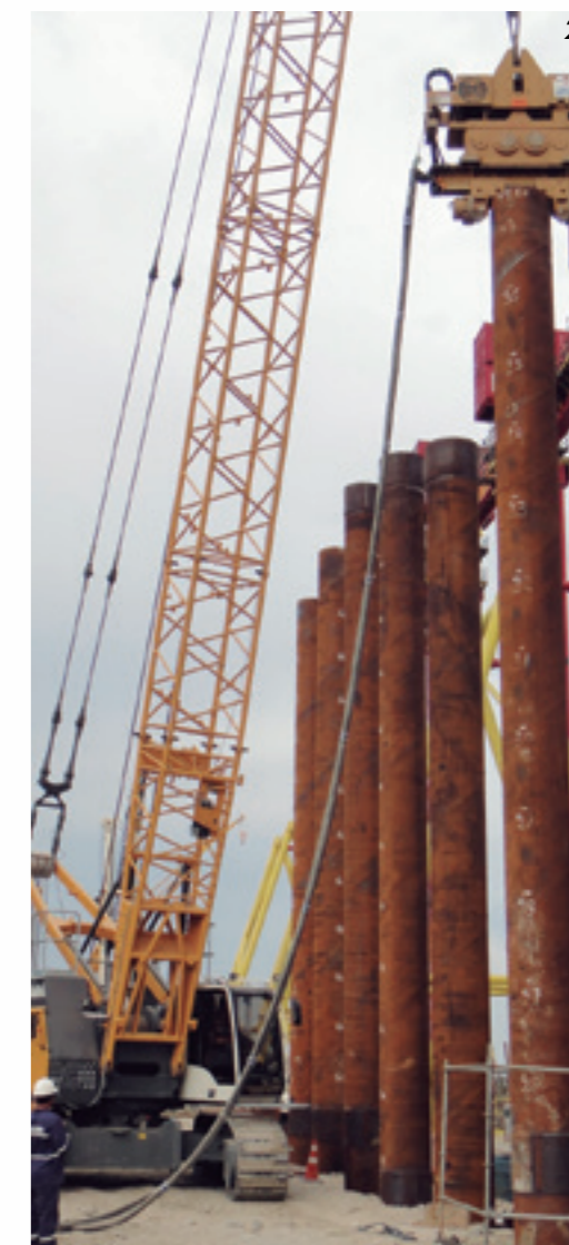
2 - Cravação de estacas metálicas com uso de martelo vibratório
