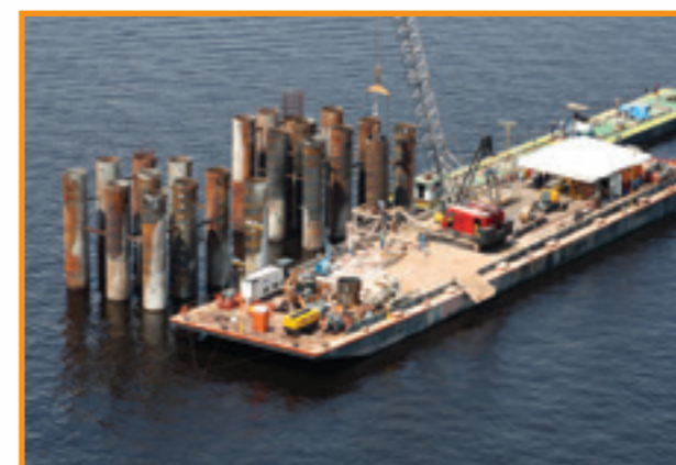
Ponte estaiada sobre o Rio Negro - apoio central Manaus - AM
