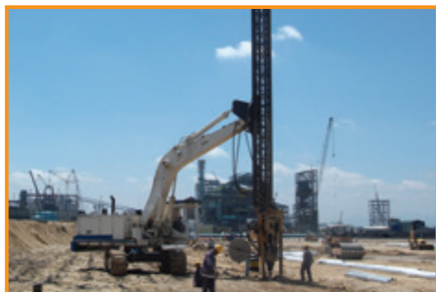
Cravação de geodreno com vibro-percussor Santa Cruz - RJ
