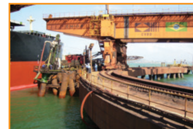
Recuperação do dolphin de atracação Porto de Tubarão - ES
