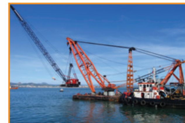
Aplicações especiais em Obras Marítimas e Fluviais
