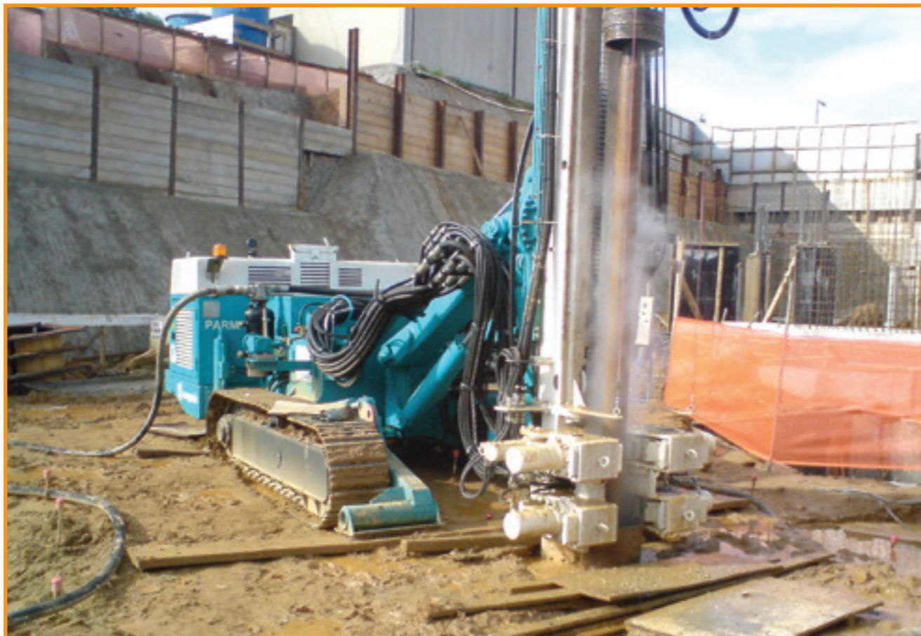
Estacas raiz em solo e rocha com uso de perfuratriz, revestimento e martelo de fundo - Barueri - SP
