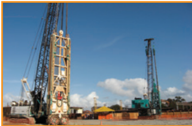
Parede diafragma em rocha com uso de hidrofresas Casagrande® FD60 e FD30
