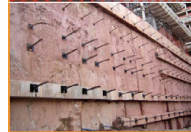
Detalhes de parede diafragma e tirantes de cordoalha executados
