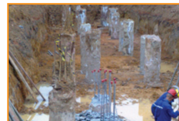
Vista das estacas hélice contínua em fase de arrasamento
