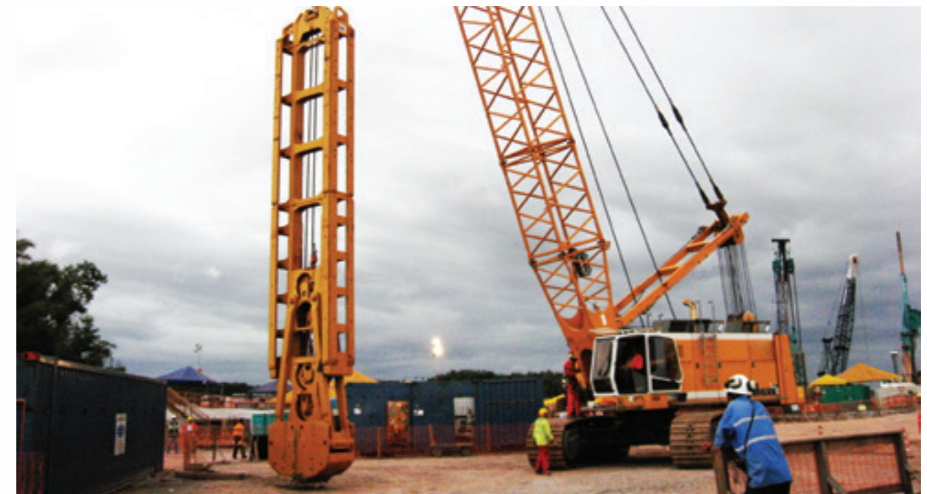
Guindaste sobre esteiras capacidade 120 tf e clam shell mecânico HD de 22 tf para parede de esp. 800 a 1.500 mm com controle de verticalidade
