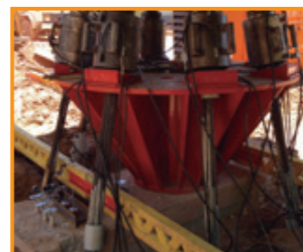
Prova de Carga Estática sobre estaca barrete embutida em rocha granulítica via hidrofresa para até 1440tf.
