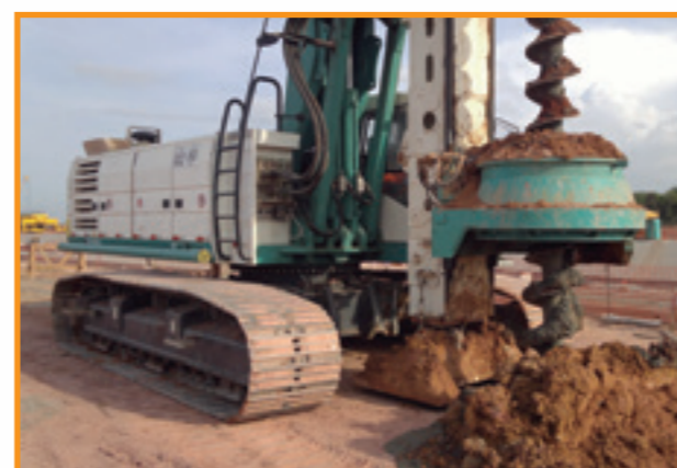
Perfuratriz hidráulica para estaca hélice contínua São Luis - MA
