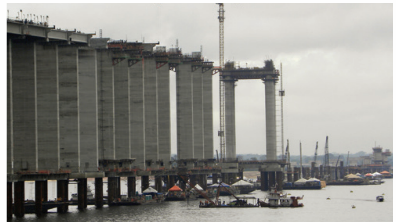
Execução de estacas escavadas com uso de camisa metálica perdida e fluido estabilizante Ponte sobre o Rio Negro, Manaus - AM
