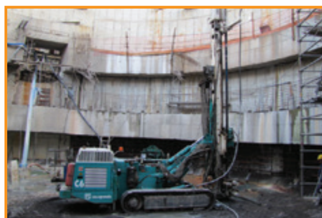
Execução de colunas de jet grouting Cubatão - SP
