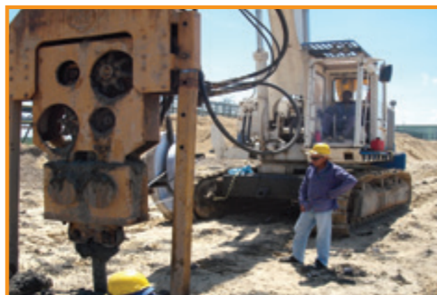
Vista do equipamento especial para cravação de geodrenos para passagem de camadas compactas
