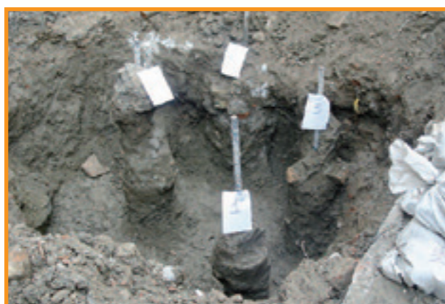
Vista das colunas executadas de MiniJet®
