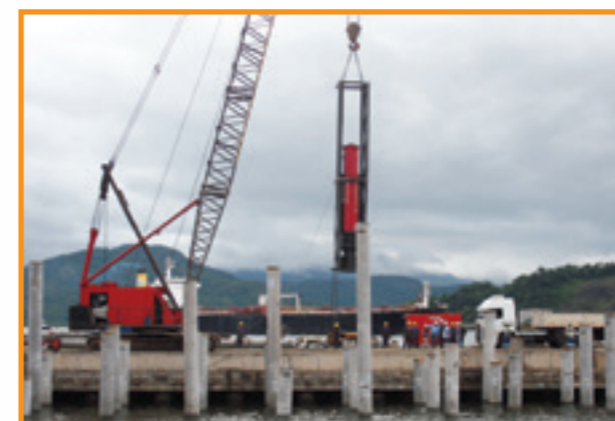
Equipamentos hidráulicos para cravação de estacas pré-fabricadas
