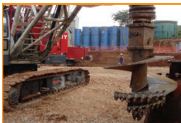
Detalhe do trado de pico para estacas escavadas em rocha
