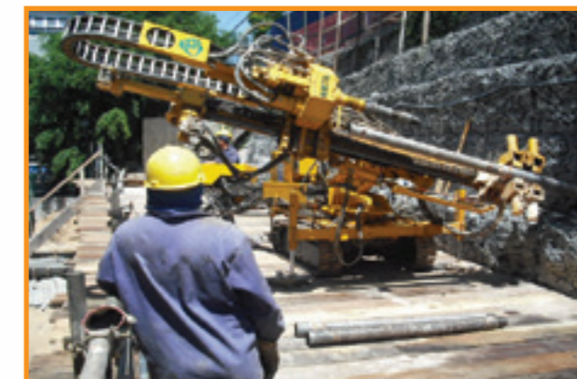
Perfuratriz hidráulica para execução de tirantes em rocha com uso de martelo de fundo
