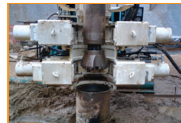
Detalhe do martelo de fundo para execução de estaca raiz em rocha
