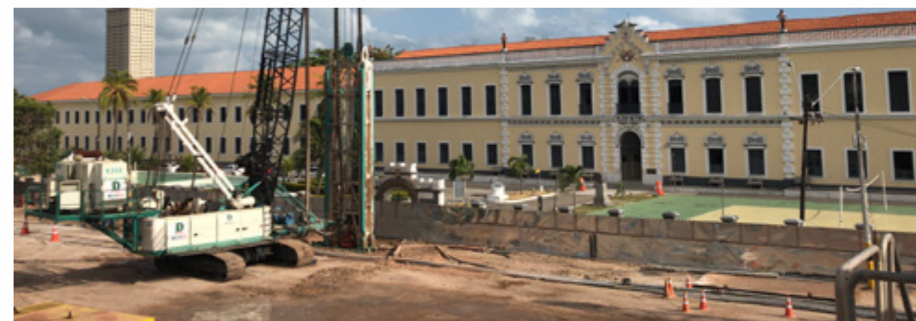
Contenções: parede diafragma e tirantes provisórios - Estação Colégio Militar Fortaleza - CE
