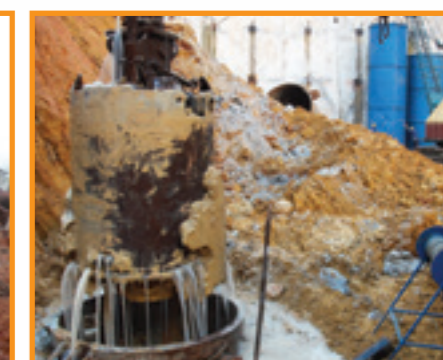
Detalhe da execução da estaca escavada com uso de polímero
