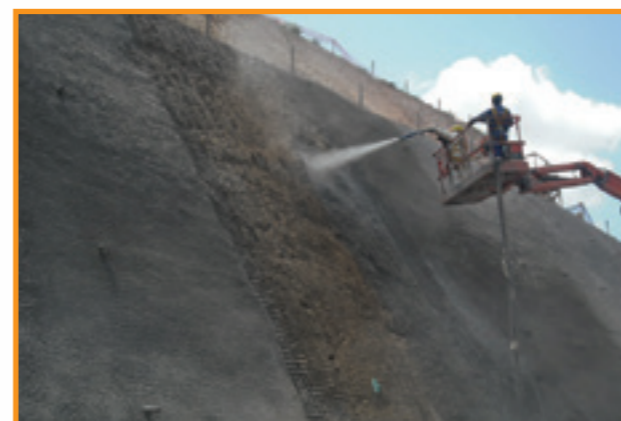
Concreto projetado em Francisco Morato - SP
