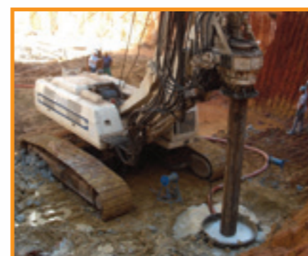
Execução de estaca escavada com uso de polímero
