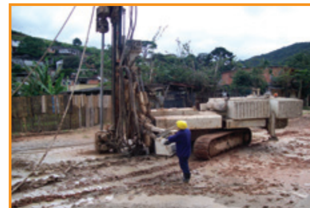
Execução de colunas de jet grouting Rio de Janeiro - RJ
