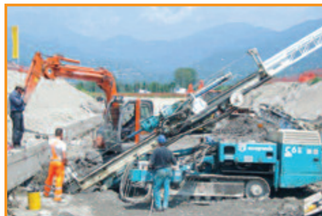
Perfuratriz para execução de colunas de MiniJet®
