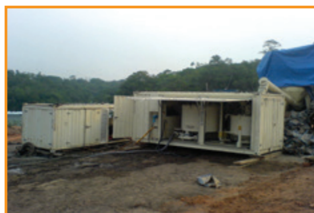
Vista do conjunto misturador e bomba de alta pressão para jet grouting - PCH em Sapezal - MT
