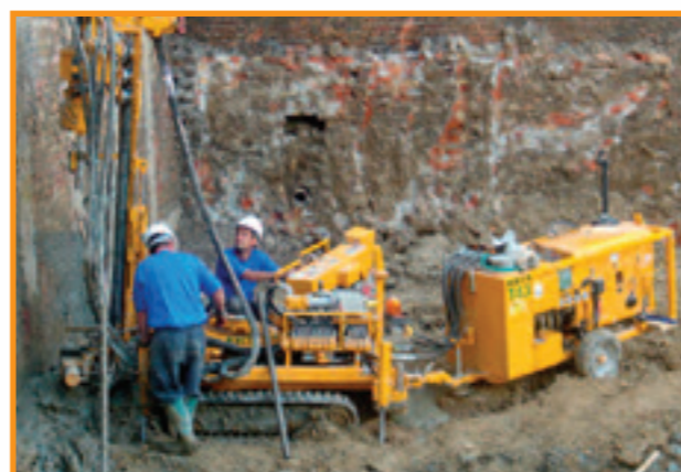
Perfuratriz hidráulica para execução de colunas de MiniJet®
