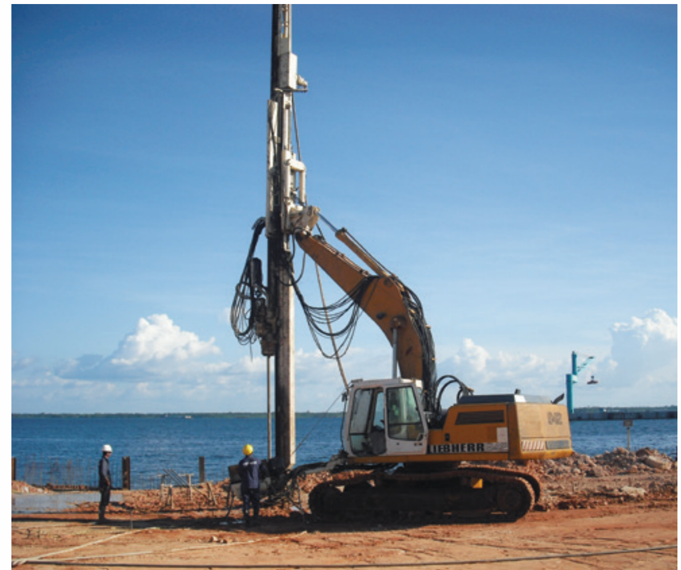
Execução de jet grouting, porto em Manaus - AM
