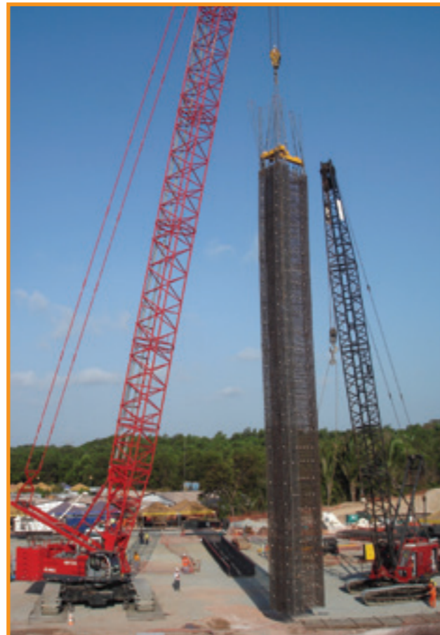
lçamento de armadura com 36m e peso de 40 tf para parede diafragma em rocha com espessura de 1m com contrafortes
