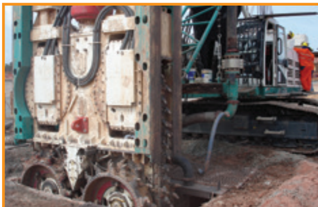
Escavação de painel diafragma em rocha. Espessura 1m e profundidade 36m.
