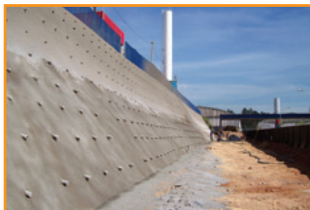
Concreto projetado em solo grapeado - Itapevi - SP
