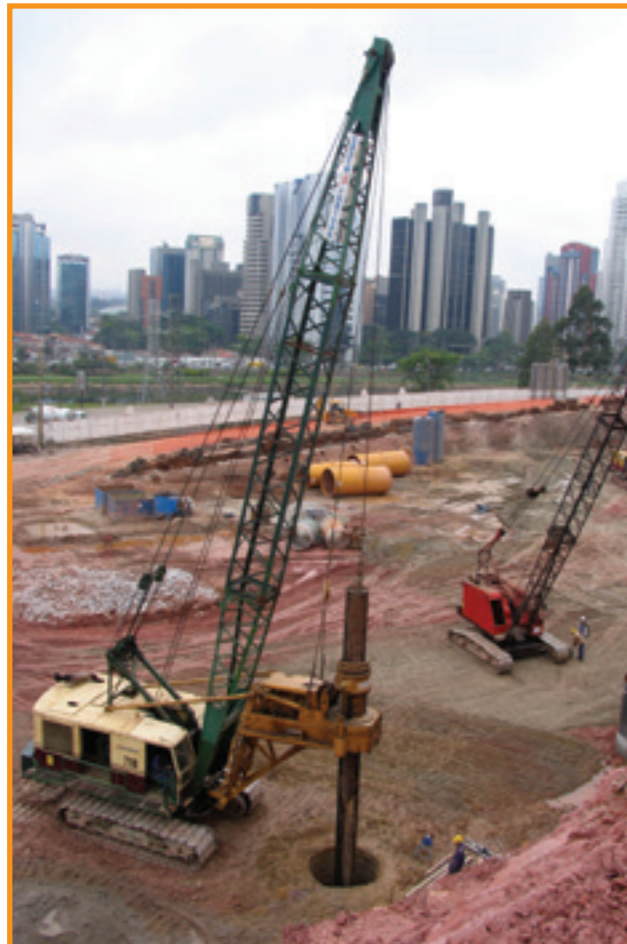
Estacas escavadas na margem do rio Pinheiros, empreendimento residencial e comercial, São Paulo - SP
