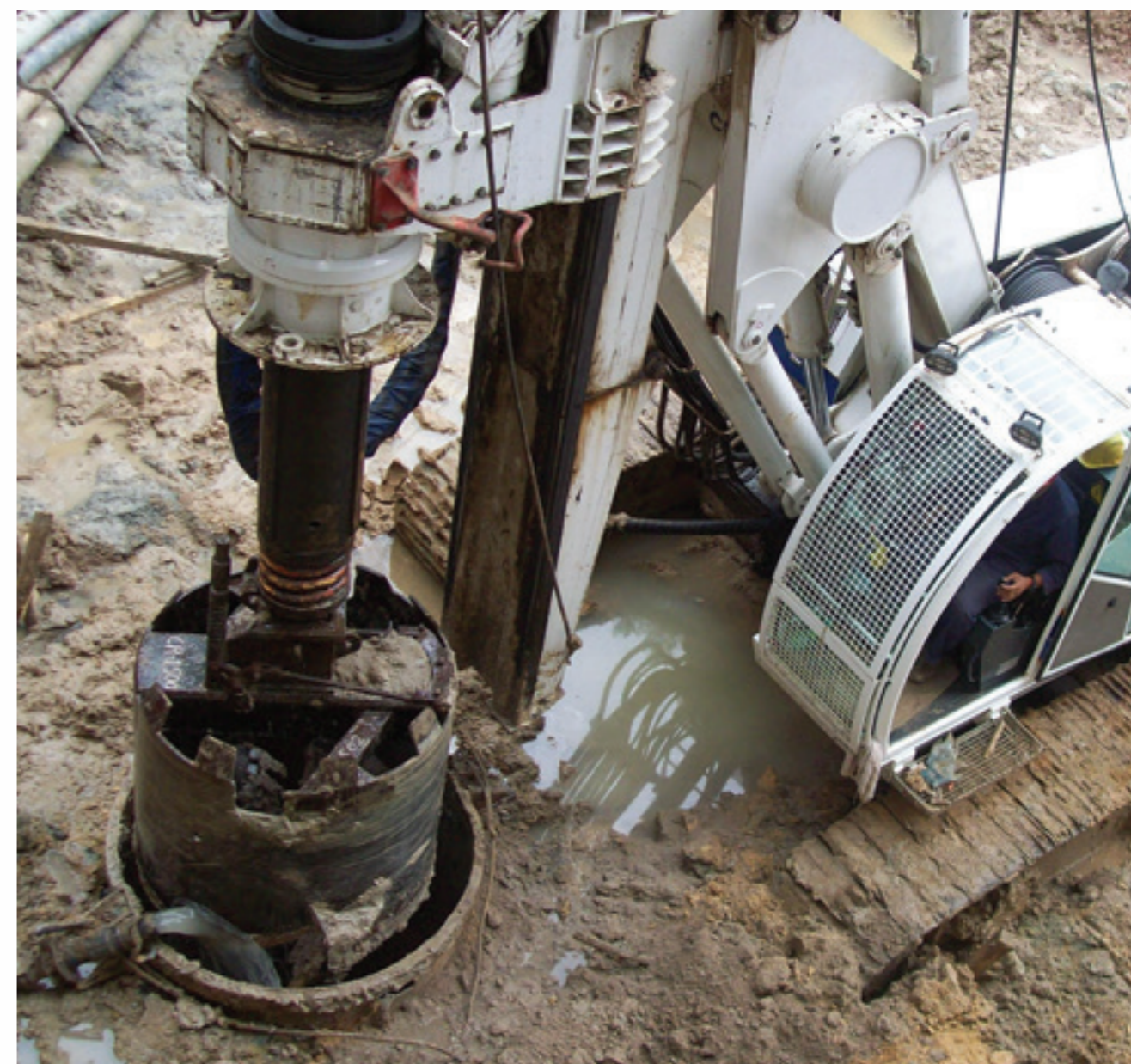
Detalhe da execução de estaca escavada - Curitiba - PR
