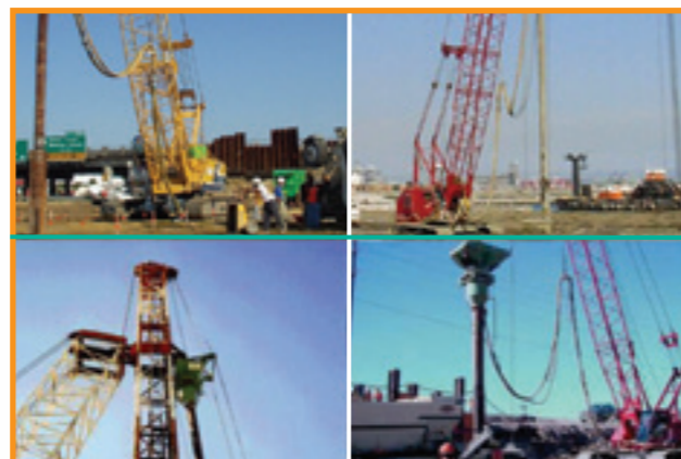
Execução de colunas de brita
